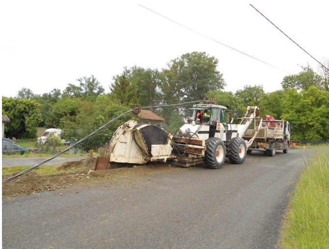
Actuellement, une « trancheuse » est utilisée pour faciliter l'enfouissement des câbles. En effet, cette machine, utilisée dans les travaux publics et l'industrie, permet de creuser, poser les câbles et remblayer la tranchée en un minimum de temps tout en réduisant la gêne des riverains. De plus, elle permet d'effectuer des tranchées de faible emprise, limitant les risques d'affaissement.
