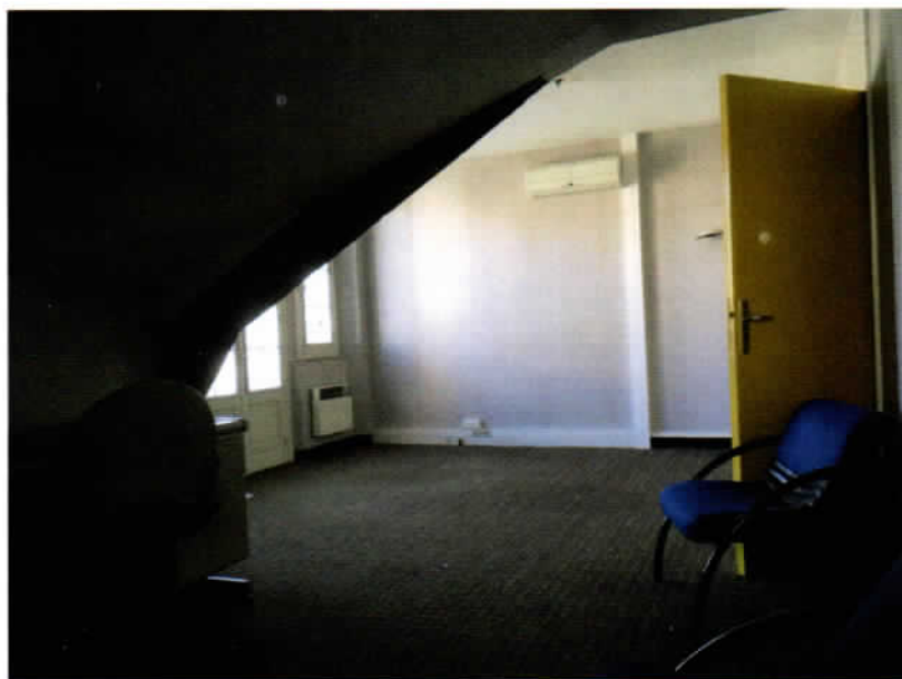
Vue T2 étage nord avant travaux séjour
