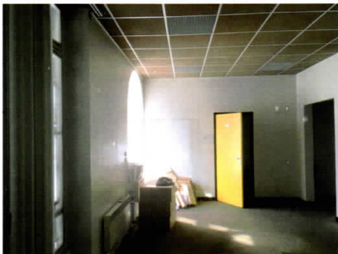
Vue T2 RDC sud avant travaux
