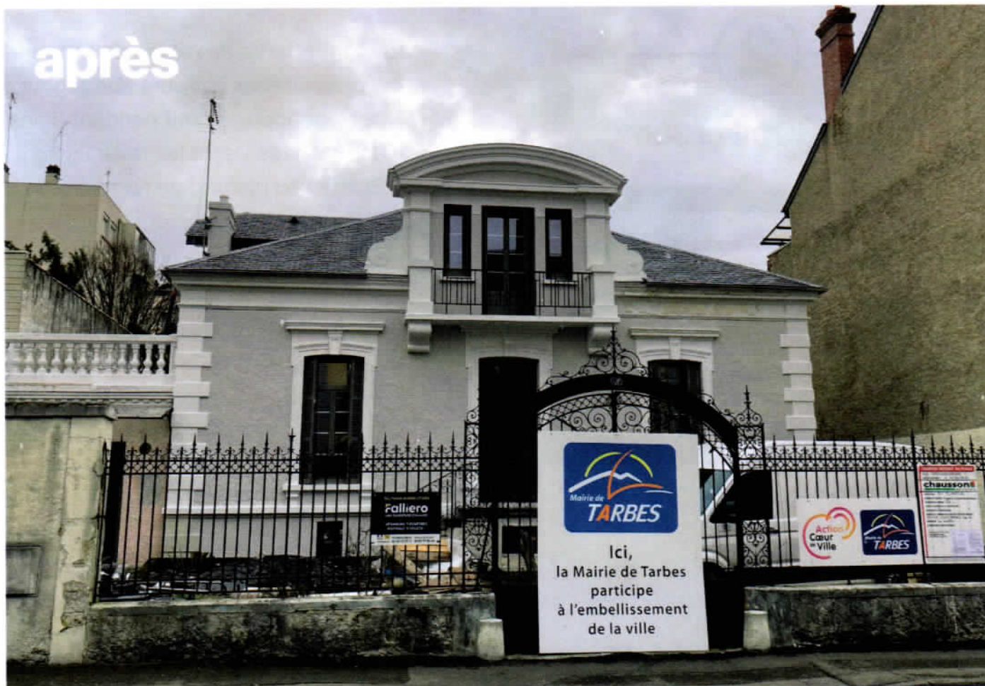
Aspect extérieur après ravalement de façades
