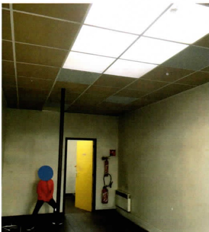
Vue T2 RDC ouest avant travaux
