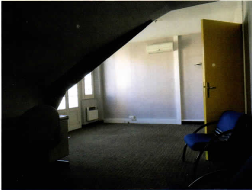
Vue T2 étage nord avant travaux séjour
