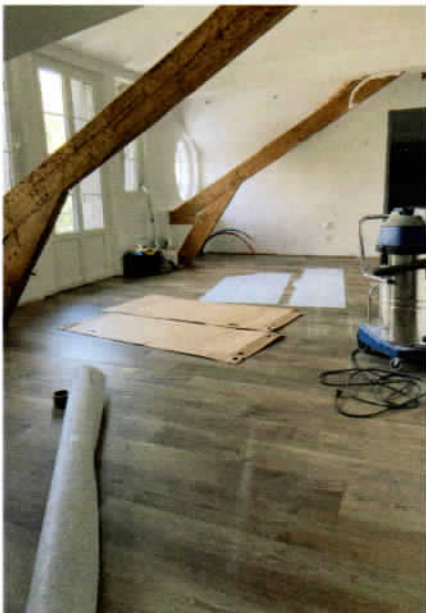
Vue T2 étage sud avant pose cuisine
