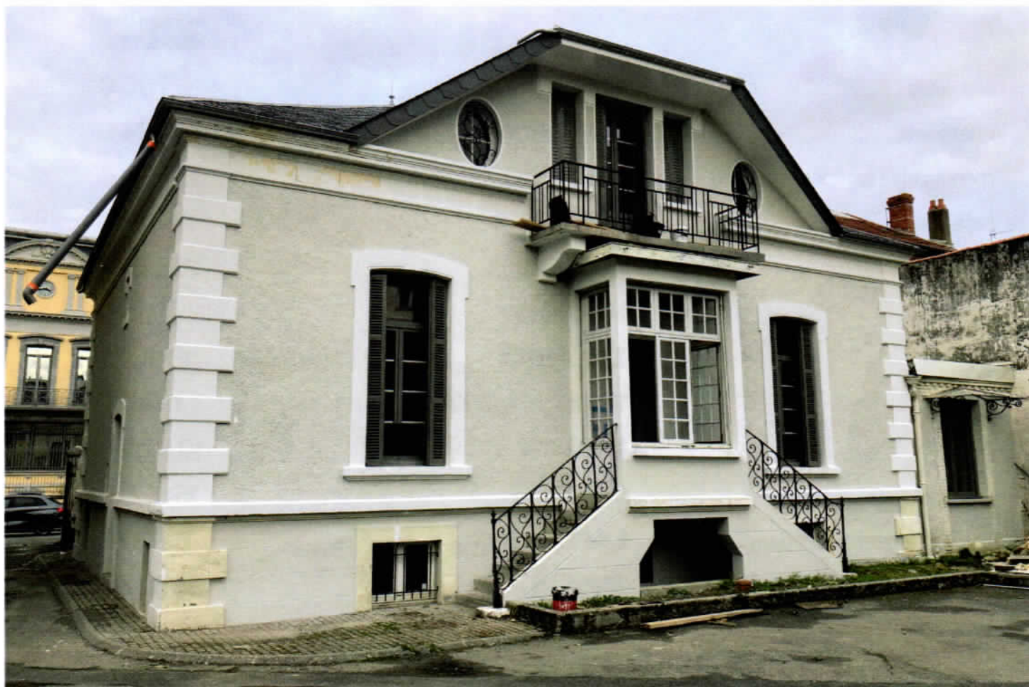
Aspect extérieur après ravalement façade sud
