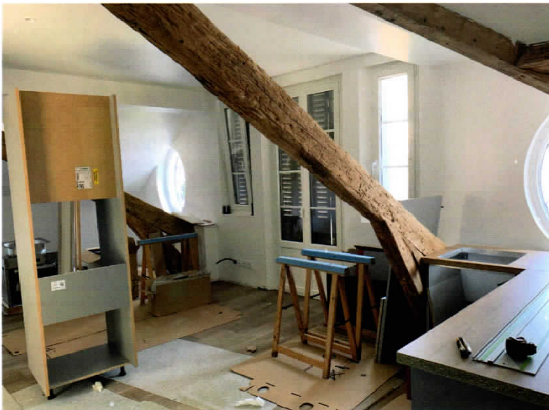
Vue T1 étage sud avec cuisine
