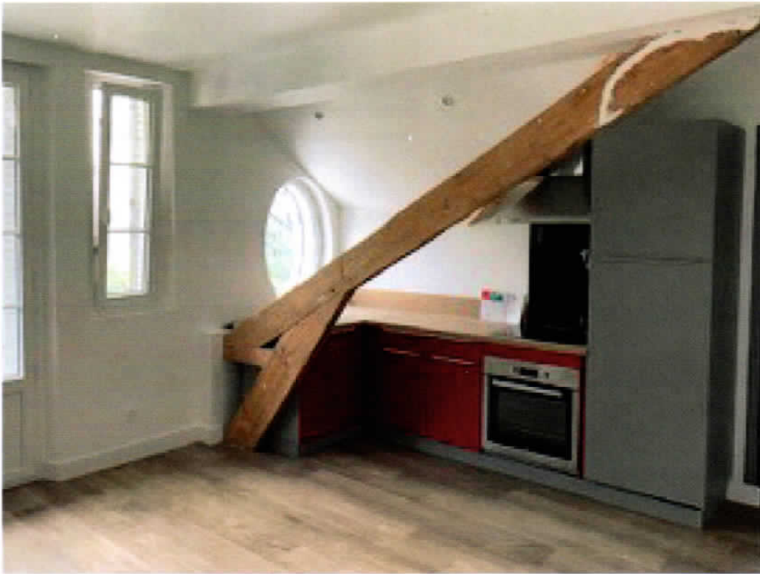
Vue T1 étage sud avec cuisine
