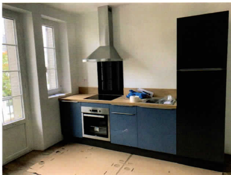
Vue T2 étage nord avec cuisine
