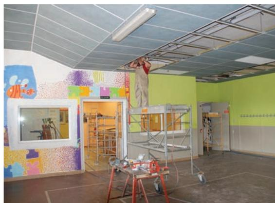
**Collège de Bagnères-de-Bigorre :** réfection des installations de chauffage, des étanchéités toiture terrasse, de la façade et du préau.
