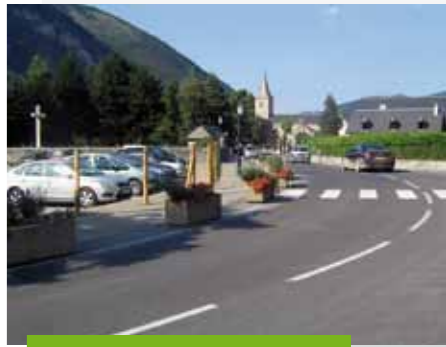
Rectification de virage RD 19
