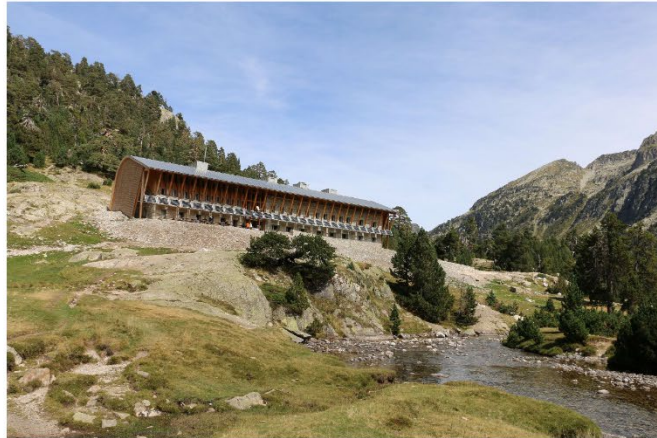
Façade sud après travaux - été
