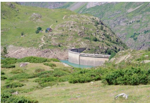
Le Barrage des Gloriettes
