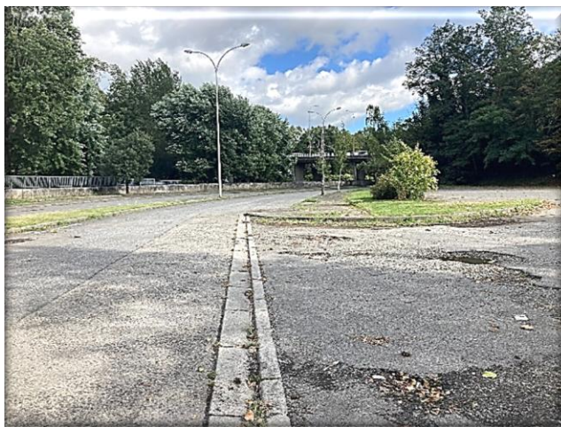
Le parking relais du Quai de l'Adour
