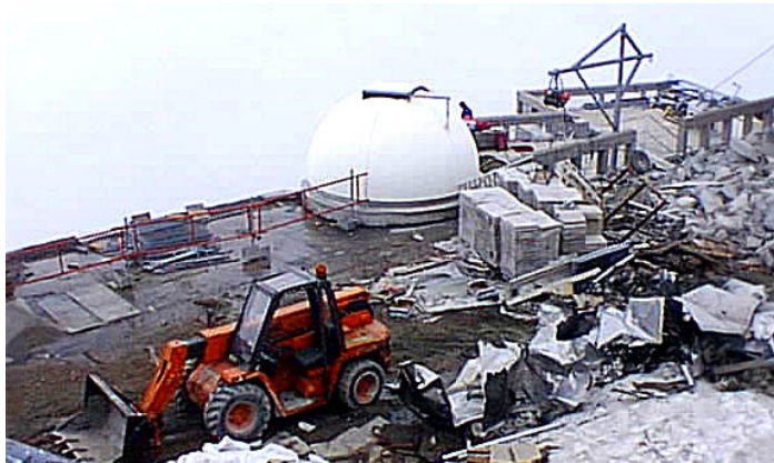
Cette photographie montre l'ampleur des travaux en 1997. La coupole du T60 est déposée dans sa nouvelle localisation sur la terrasse sud (image Maxime Muller).
