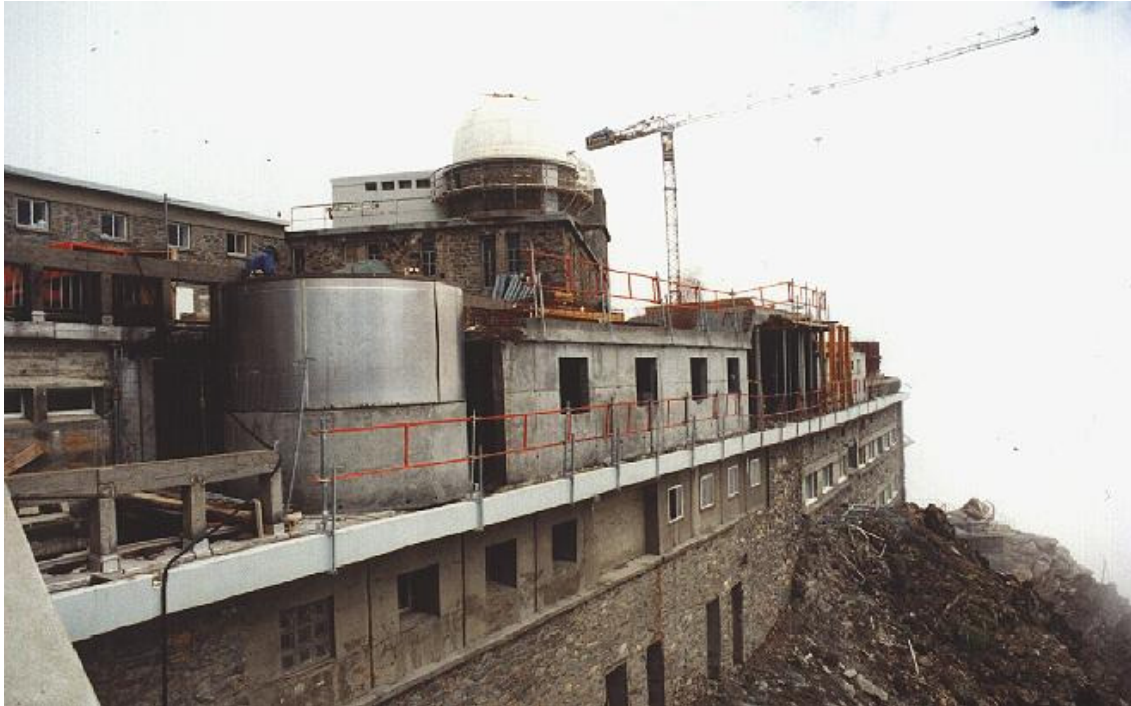
La face sud de l'observatoire en 1997 lors des grands travaux. La structure de la coupole du T60 est visible au premier plan (image Maxime Muller).
