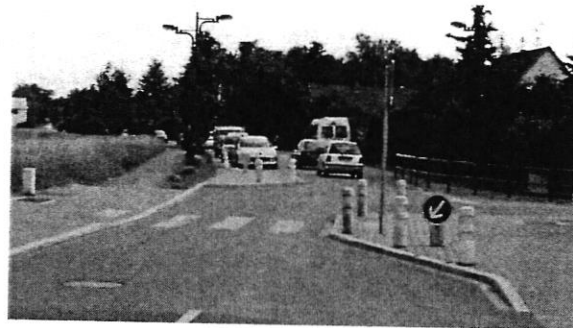
Décrochement vertical de type plateau surélevé (à gauche) et décrochement vertical de type écluse (à droite)
