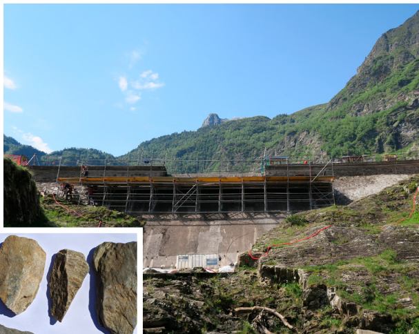
Les pierres sont sélectionnées pour assurer l'intégration paysagère de l'ouvrage.
